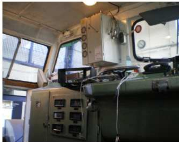
Der Führerstand beim Einbau des neuen Zugfunks
