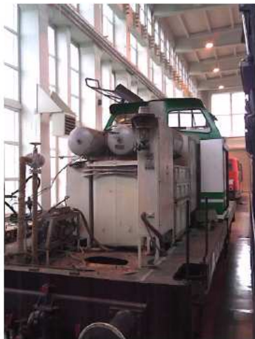
Der Heizkessel ist ausgebaut ....
